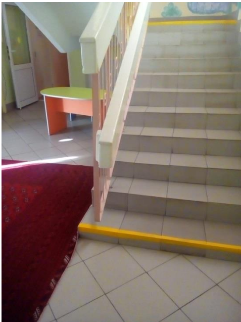
Фото № 13. Лестничный марш на второй этаж
